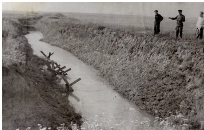
Противотанковый ров на Куйбышевском шоссе, вырытый к обороне г. Рязани в октябре 1941 г.
